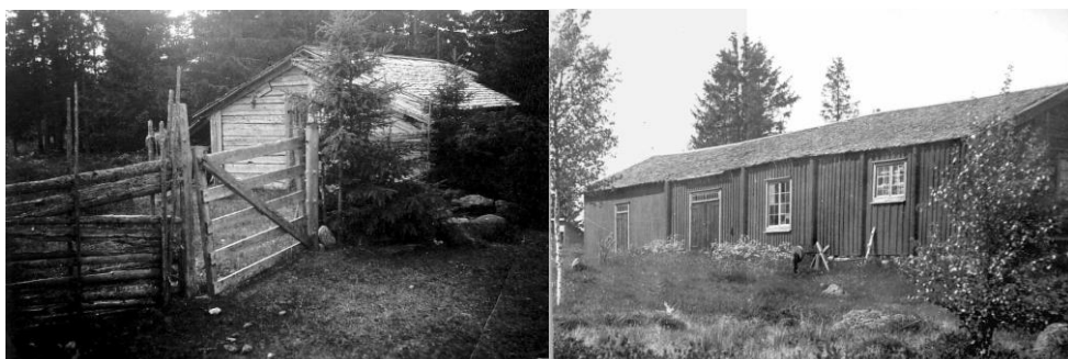
Figur 6. Bild till vänster visar sommarladugården vilken är belägen mitt på fastighetsgräns mot Holmön 3:7. Bild till höger visar ladugården vilken är riven, den gamla grunden ligger dock mycket nära fastighetsgränsen mot planområdet. Källa: Upphovsman okänd.
